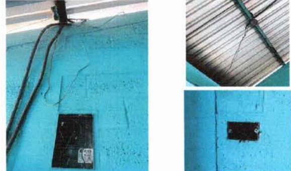
FOTO 4: La red eléctrica se encuentra en malas condiciones el cual puede provocar un cortocircuito poniendo en riesgo la integridad de las personas y estudiantes.
