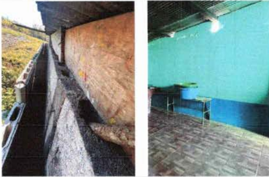
FOTO 1: Se observa la falta de solera de corona lo cual representa un riesgo a la infraestructura.
